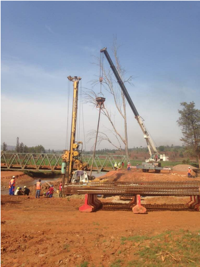
RN 15 Gitega Bridge, Burundi
