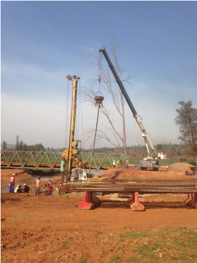
RN 15 Gitega Bridge, Burundi
